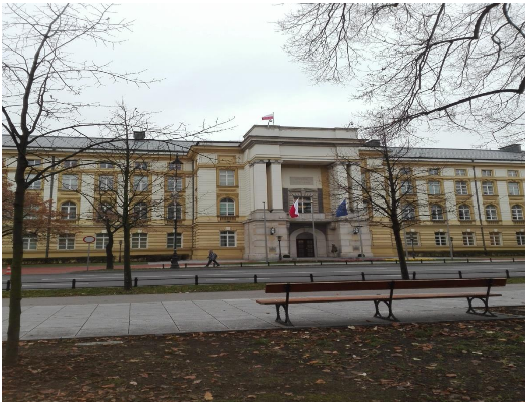
Miejsce, w którym pracował Marszałek Piłsudski. Budynek sąsiadujący z Głównym Inspektoratem Sił Zbrojnych. Obecnie siedziba Gabinetu Rady Ministrów z premierem na czele.
